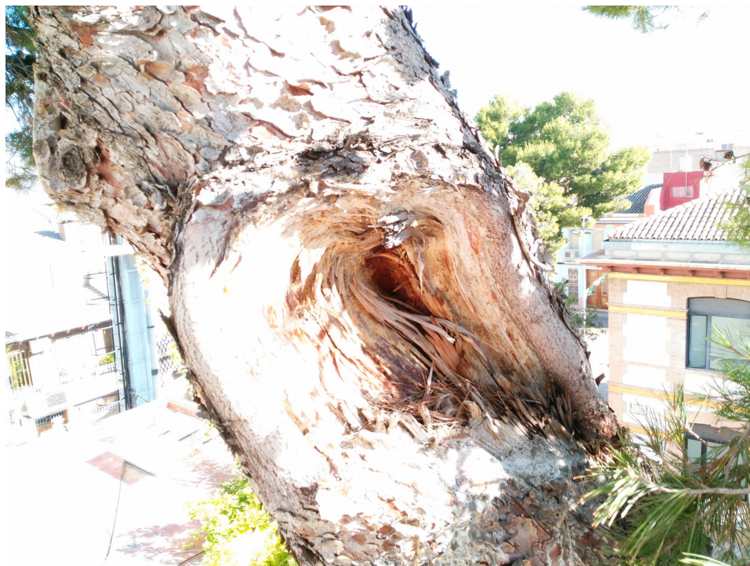
Imagen: Desgarro ya existente.
